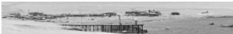
Figura 2 Muelle Caleta Constitución
